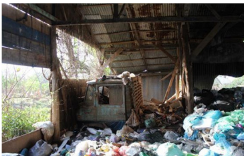
Figura 6 - Aspecto de uma central após a enchente de maio/2024
