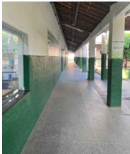
Figura 3 - Extensos corredores da instituição
