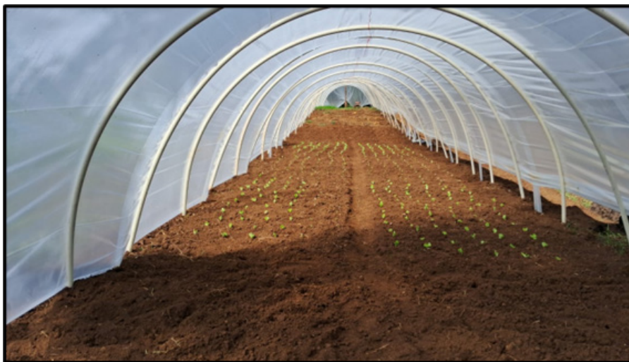
Construção da estufa de Márcio Steimbach, fevereiro de 2024.
