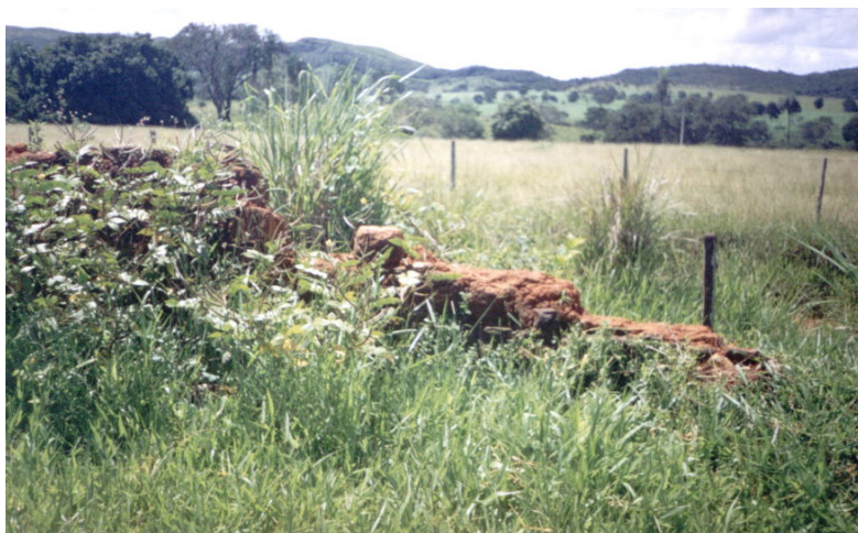
Figura 6: Alicerces de muros e paredes de antigas casas
